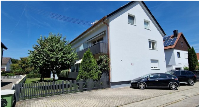
Ansicht von der Strasse
